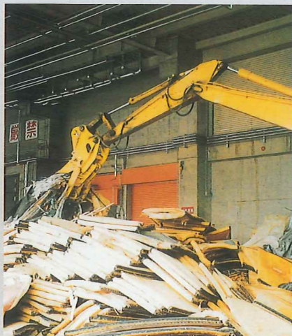
現場作業中の HS-L
