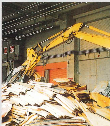
現場作業中のHS-L
