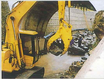
現場作業中の ALPHA STONE
