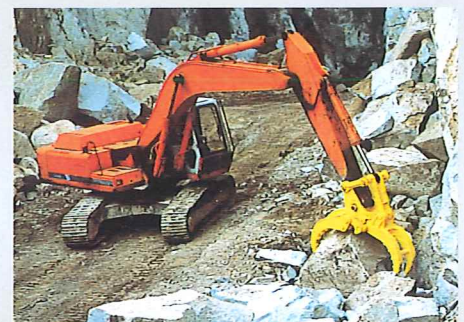
現場作業中のBIG STONE
