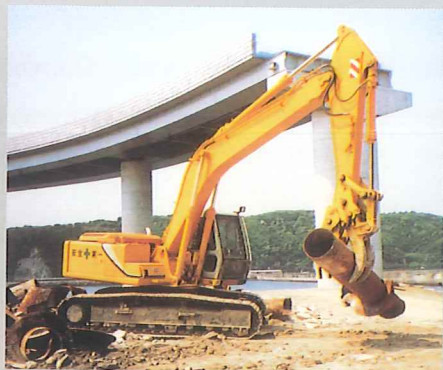
現場作業中の IRON CLAW-N
