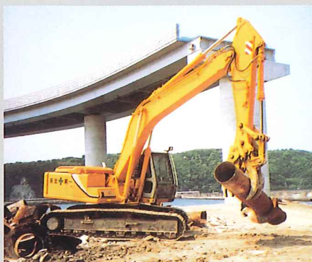
現場作業中の IRON CLAW-N
