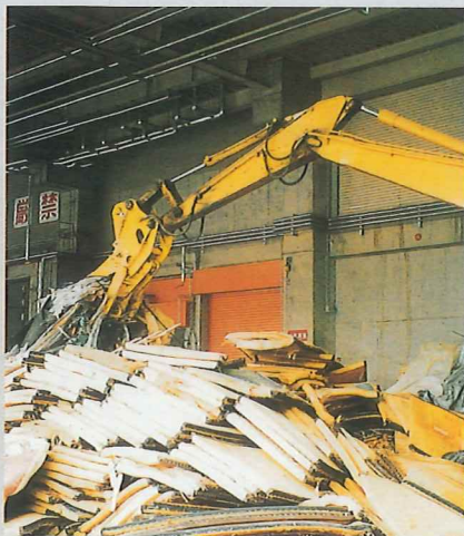
現場作業中の HS-L
