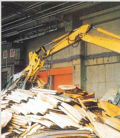
現場作業中のHS-L
