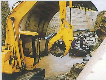
現場作業中の ALPHA STONE
