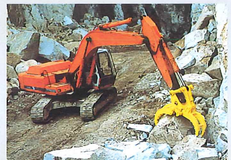
現場作業中のBIG STONE
