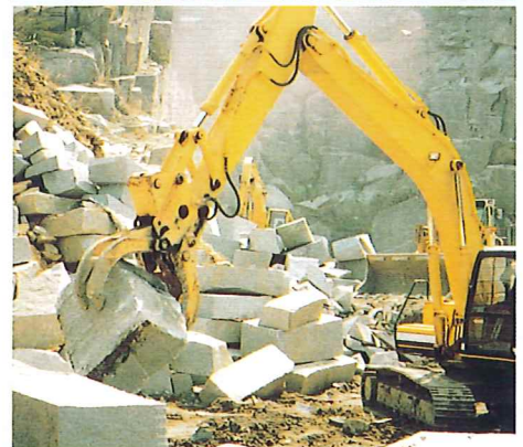
現場作業中のBIG STONE
