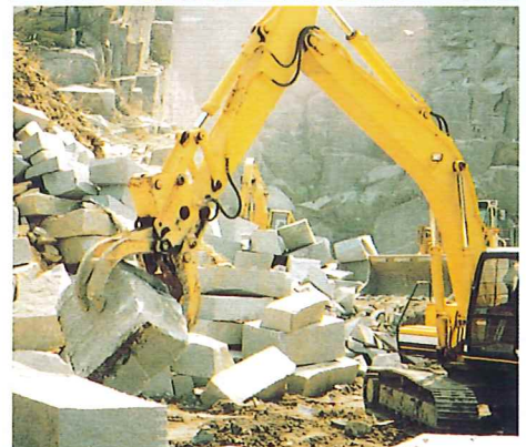
現場作業中のBIG STONE
