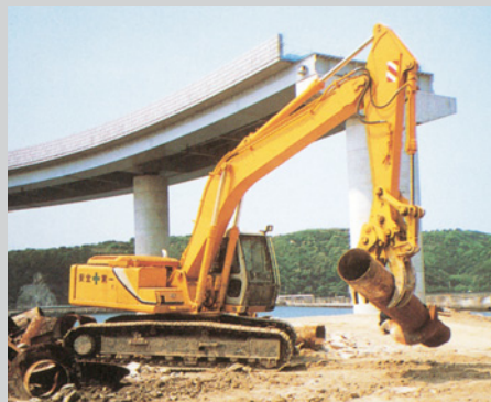
現場作業中のS-N
